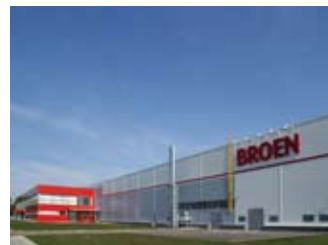
Производственный комплекс BROEN в Коломне
