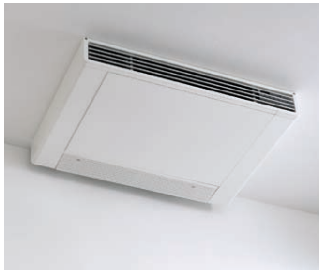
Фанкойл закреплен на потолке
